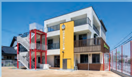
こども園施工事例
